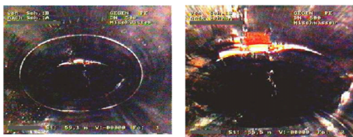
Фиг. 4: деформация на тръба от полиетилен с висока плътност (HDPE) в Германия.
