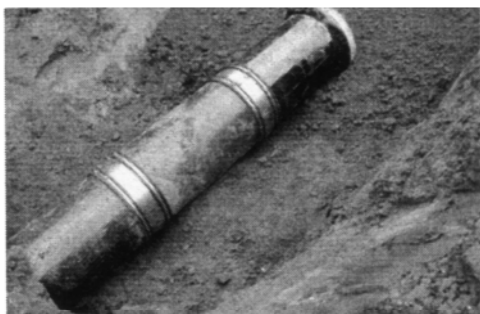
Ремонт на повредени тръби
